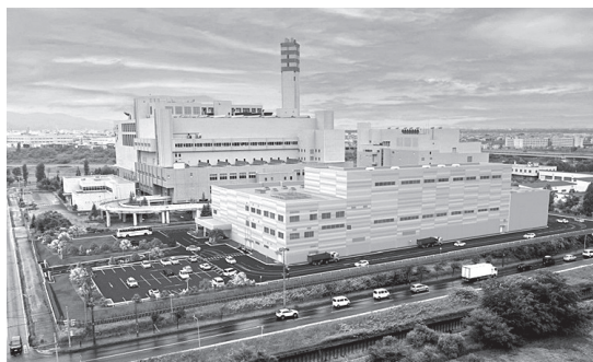
白石破碎工場(手前側)完成イメージ(タクマの発表資料より)
